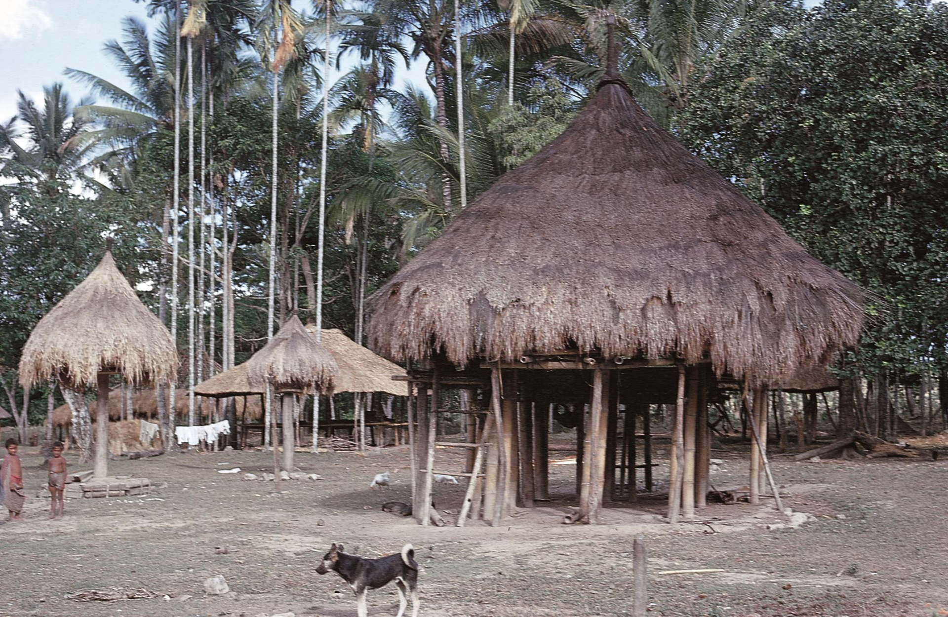
Habitação e celeiros construídos sobre altos pilares (1972)
