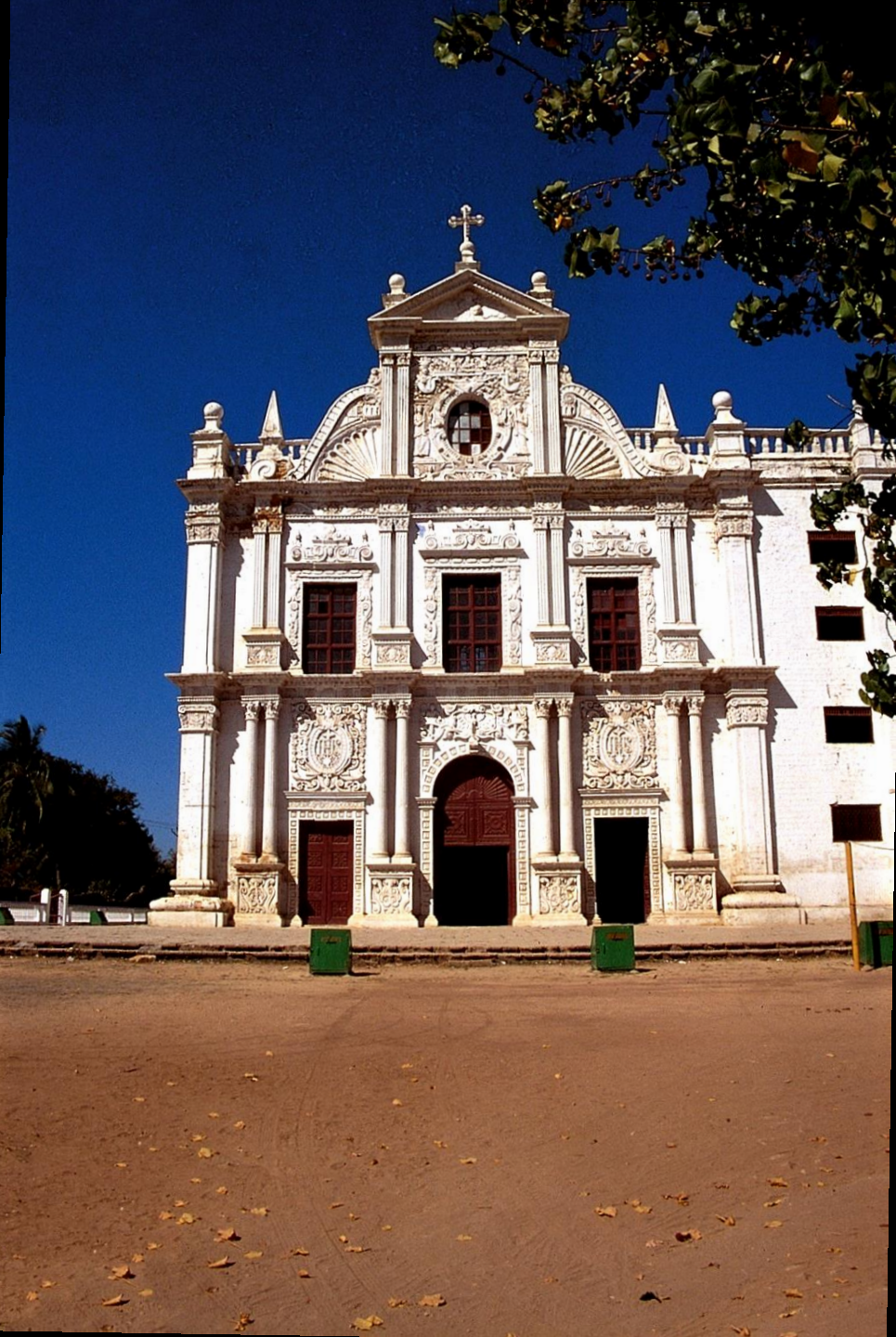
Fachada principal da Sé (1996)
