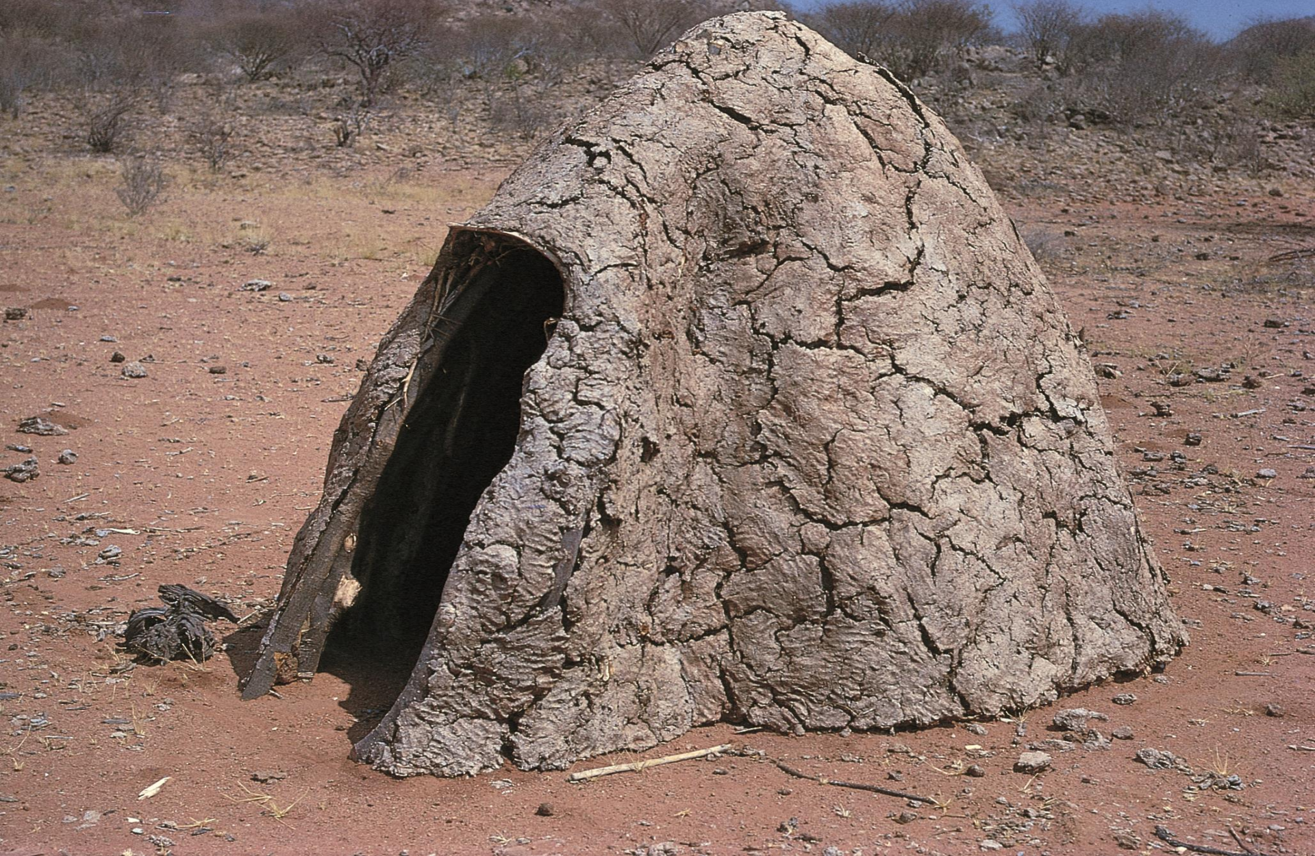
Revestimento de uma cabana com bosta seca e terra (1968)
